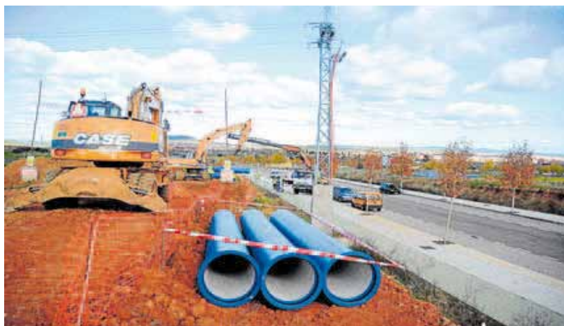
Tuberías de fibrocemento que se empezaron a poner en el anillo perimetral de la red. hoy
