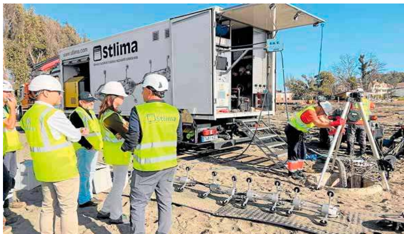
Imagen de los trabajos de instalación de una manga en el saneamiento de Estepona y Marbella. sur
